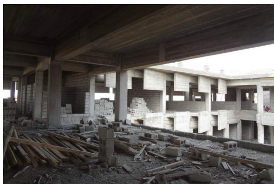
شکل ۴-۱۱: پروژه ساخت مهمان‌خانه نقوش
