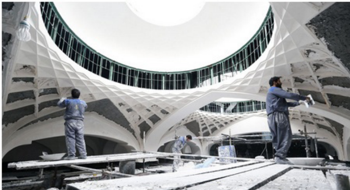
شکل ۴-۱۹: اجرای پروژه صحن حضرت زهرا (س)
