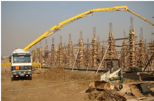
شکل ۴-۱۴: پروژه ساخت عبادتگاه کلدانی در بابل
