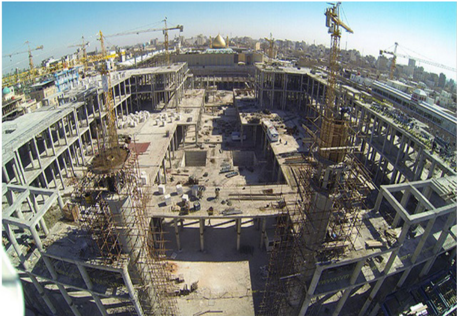
شکل ۴-۱۸: پروژه ساخت صحن حضرت زهرا(س)
